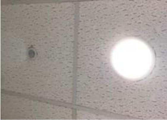
9. Podrás ahorrar hasta el doble de energía si implementamos detectores de presencia para que las luces se enciendan y apaguen automáticamente.
